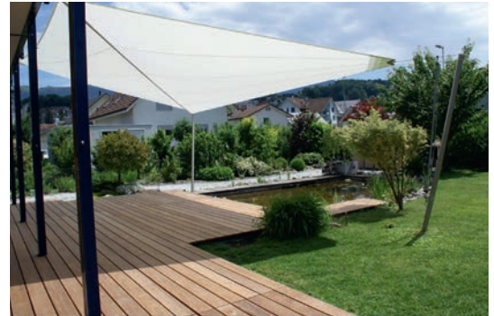
Gartenbau – schonender Einbau des Sonnensegels ohne Beschädigung des Geländeumfeldes
